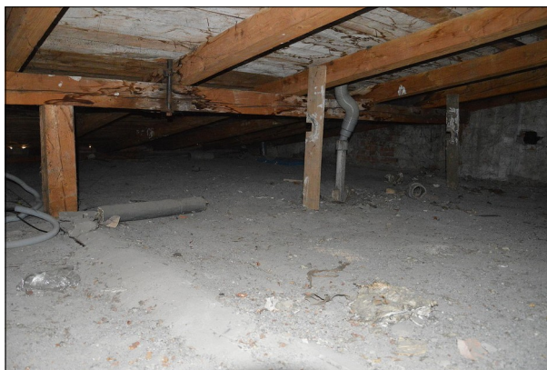
Konstrukce pultové střechy, mezi zdí a pozednicí prosvítají vstupní štěrbiny na půdu.
